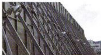
プラント工場
